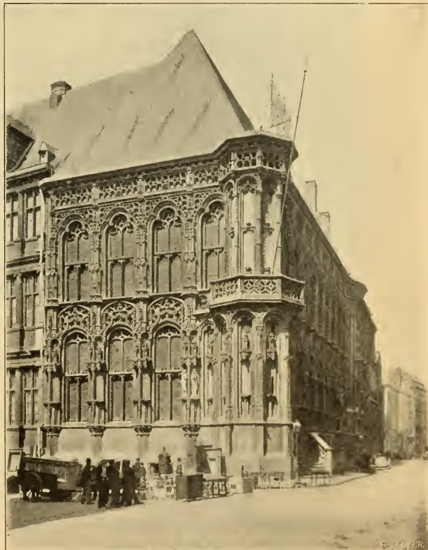
Abb. 19. Das Stadthaus. Gotischer Teil.
